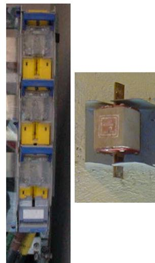
BASE BTVC CON EXTRACCION FUSIBLE DE CUCHILLAS
