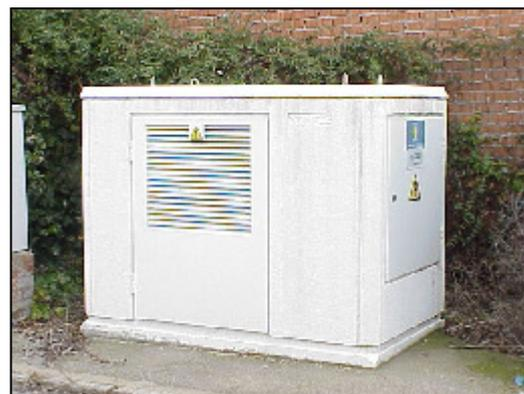
Instalación provista de uno o varios transformadores reductores de Alta Tensión (tensiones 15 kV ó 20 kV) a Baja Tensión (230V/400V), con la aparamenta precisa y protegidos bajo envolvente.
