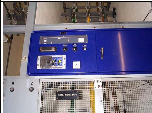
Protecciones de una posición de línea
