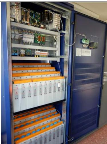
Fuente de alimentación en c.c de una subestación
