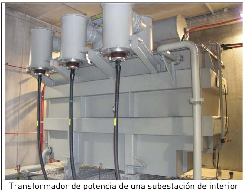
Transformador de potencia de una subestación de interior
