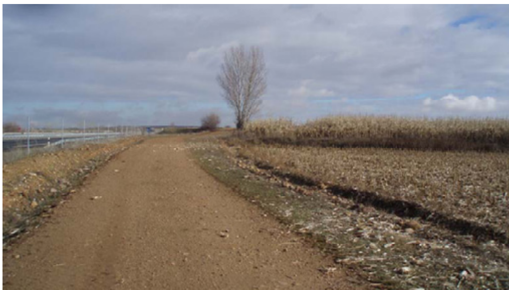
Tramo A6-A7. Al fondo vértice A7, antes del cruce con el paso elevado de la CV-1941 sobre la autopista AP-71
