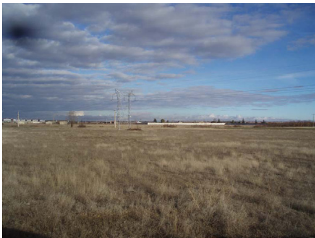
Tramo A13-A14. Cruzamiento con LAT 132 kV Hospital-Eras de Renueva.
