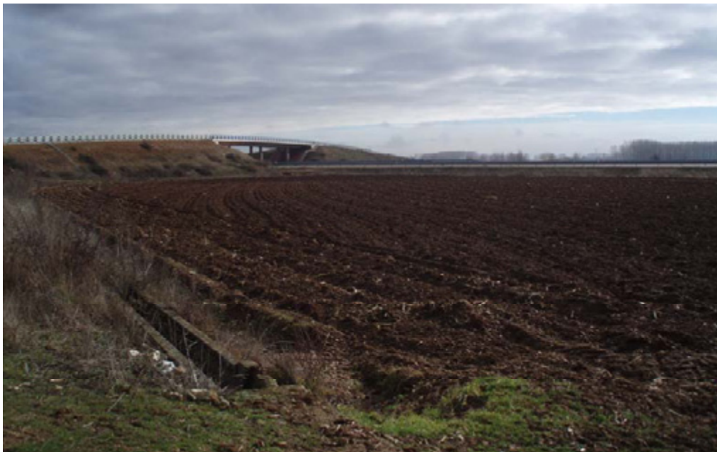
Entorno vértice A4, al fondo cruce de la autopista AP-71 con la carretera CL-621.
