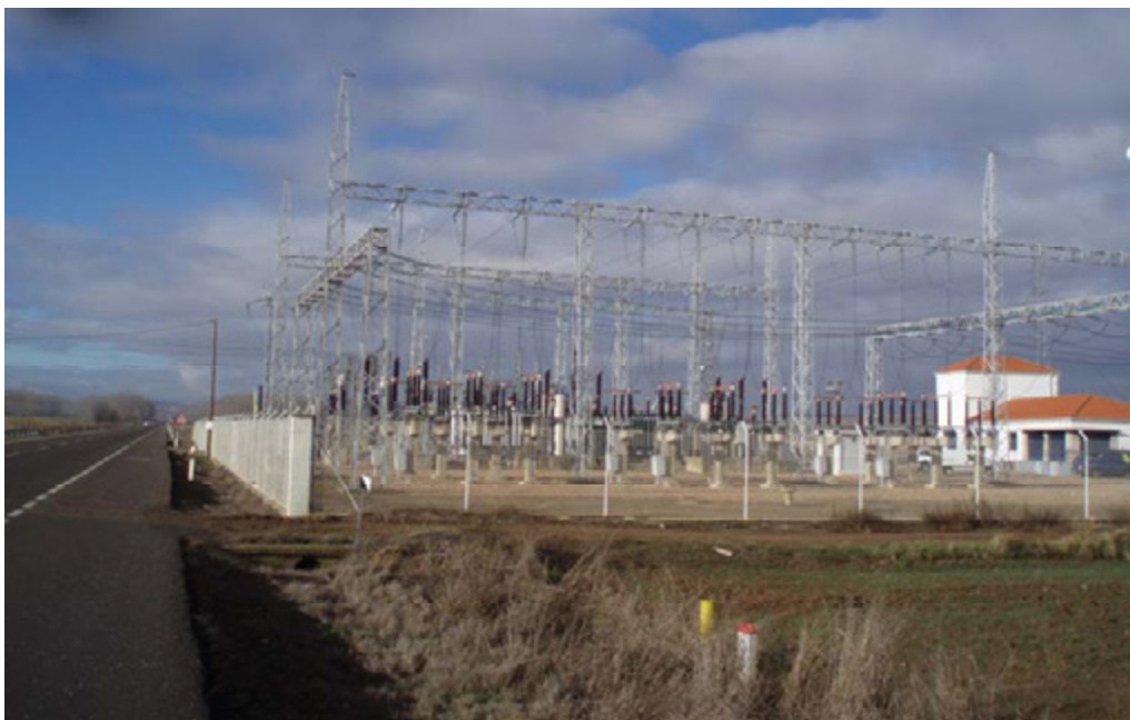
Tramo A0-A1, cruce con la carretera N-120.
