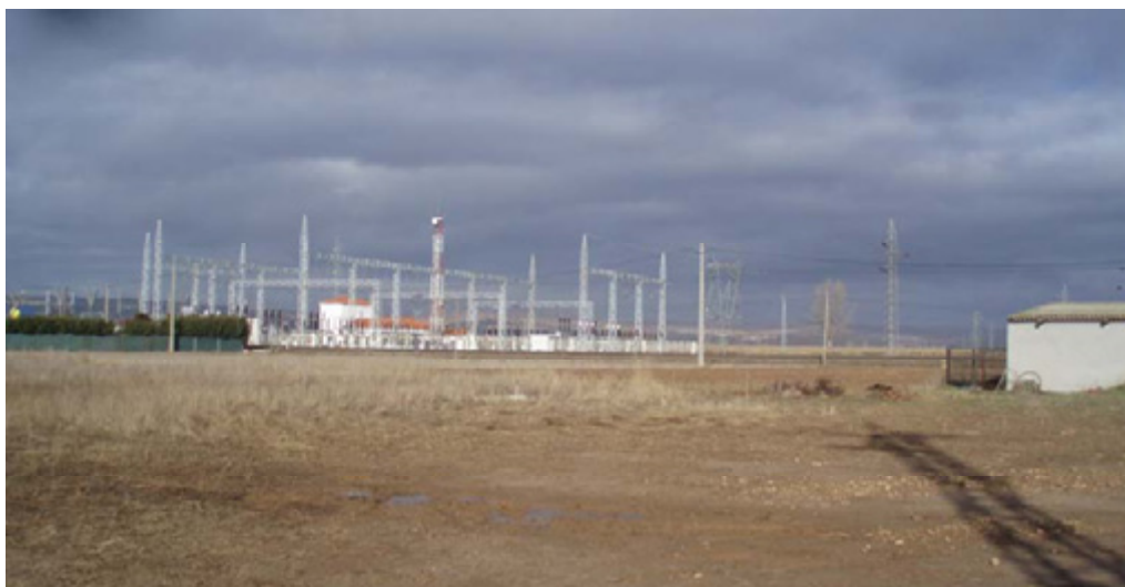
Tramo A0-A1, visto desde el vértice A1 hacia la subestación
