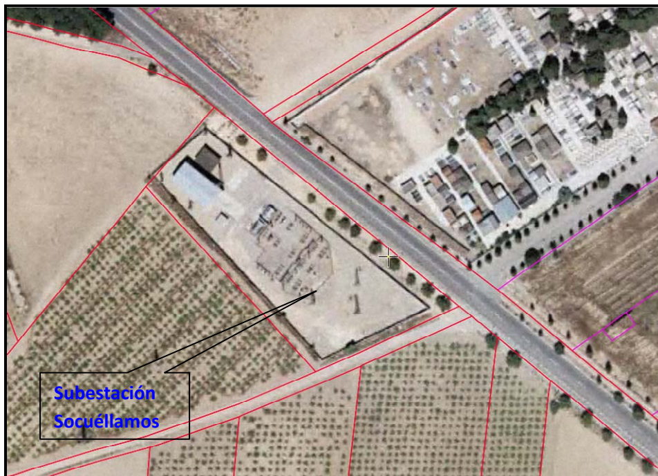
Origen: Subestación Socuéllamos.
