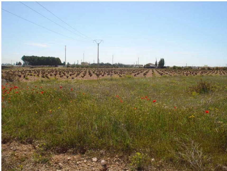
Foto N° 3: Vista desde el vértice V2 hacia la subestación
