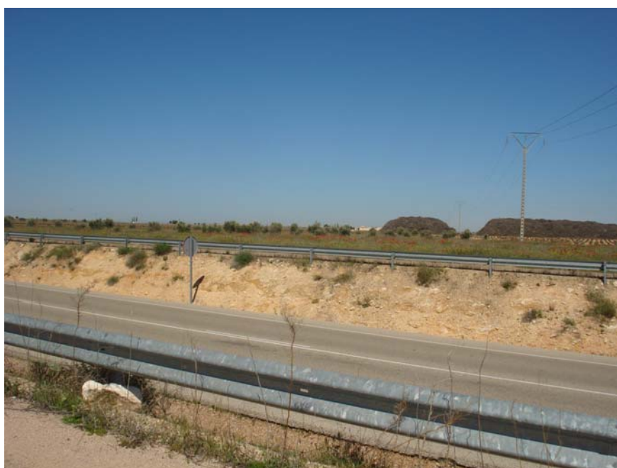
Foto N° 4: Vista desde vértice V2 hacia V3. Cruce de la carretera
