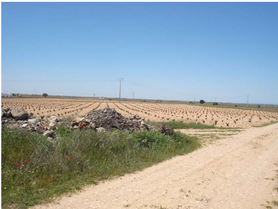
Foto Nº 9: Cruce con la Línea existente Alcázar I – Socuéllamos. Entre vértice V7 y V8.
