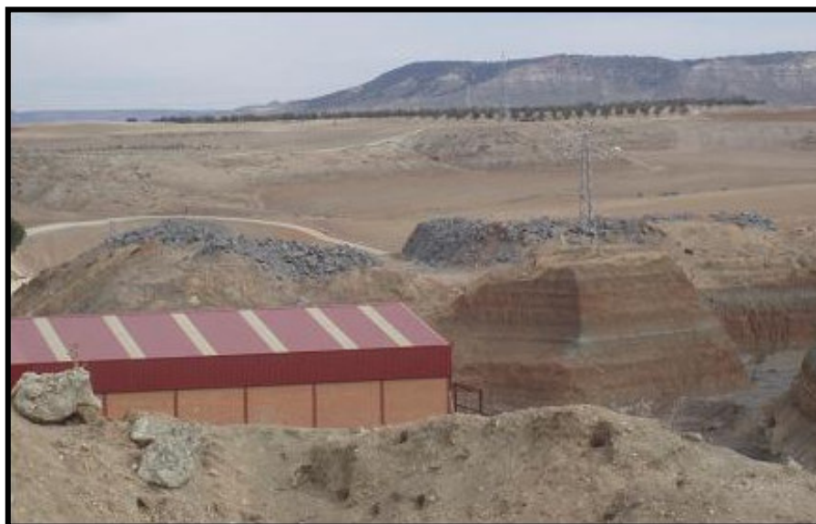
FOTO 7. DETALLE APOYO N° 25 (ALTERNATIVA A) EN LA CONCESIÓN DE EXPLOTACIÓN LOECHES-VALDERRIVAS.
