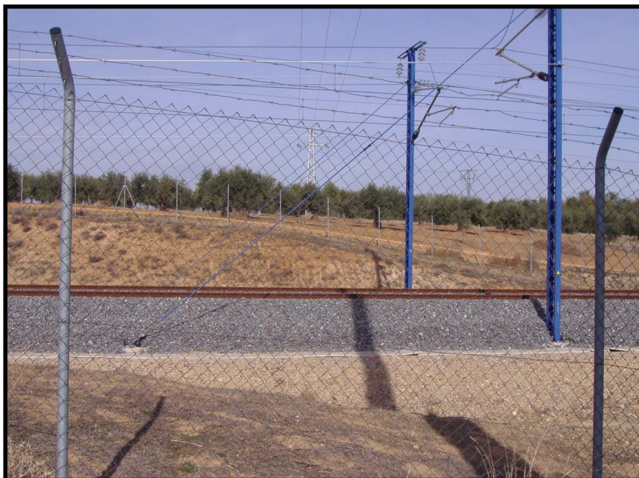
FOTO 15: CRUZAMIENTO VÍAS DEL AVE
