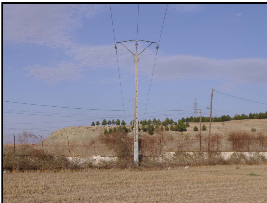
FOTO 5. APOYO N° 10 (ALTERNATIVA A) Y UBICACIÓN APOYO N° 2 (ALTERNATIVA B)
