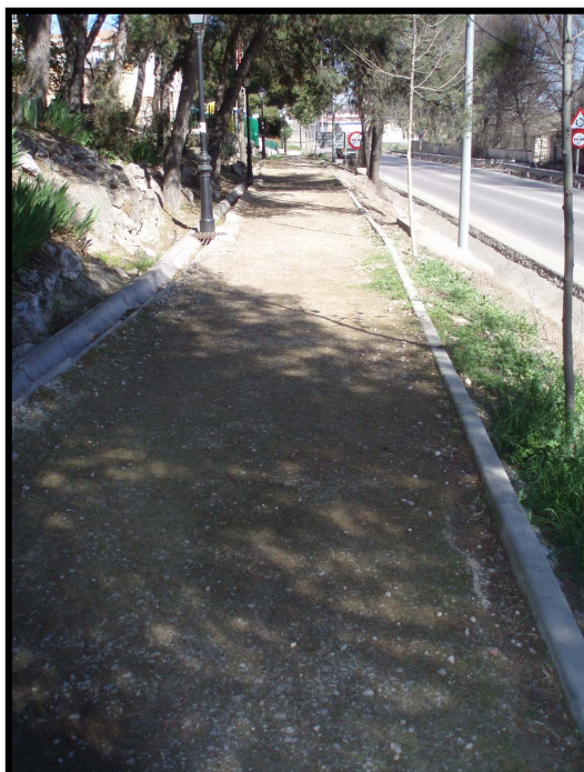
FOTO 4. CAMINO ASFALTADO POR DONDE DISCURRE EL TRAMO SUBTERRÁNEO DE LA ALTERNATIVA B
