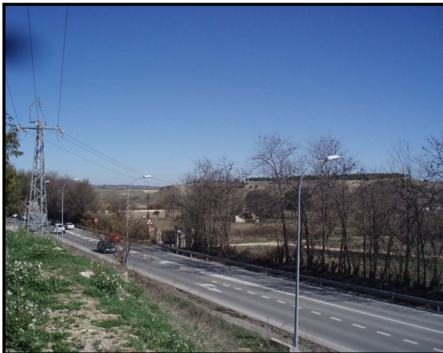
FOTO 3: CRUCE CARRETERA M-300 DESDE APOYO Nº 8 DE LA ALTERNATIVA A
