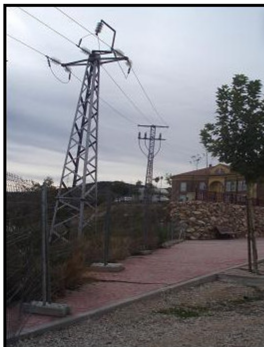
FOTO 2: VANO ENTRE LOS APOYOS 7 Y 8 DE LA ALTERNATIVA A
