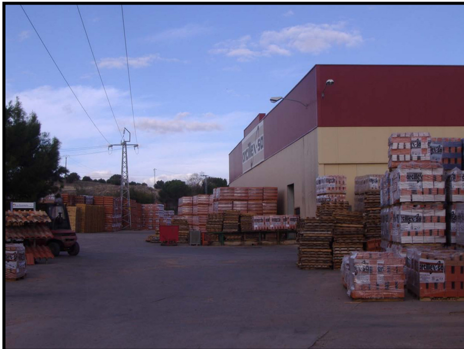
FOTO Nº 11. APOYO Nº 44 (ALTERNATIVA A) DENTRO DE LAS CERÁMICAS ARCILLEX
