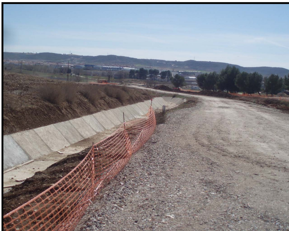
FOTO 12. ZONA DE OBRAS AMPLIACIÓN CARRETERA M-224
