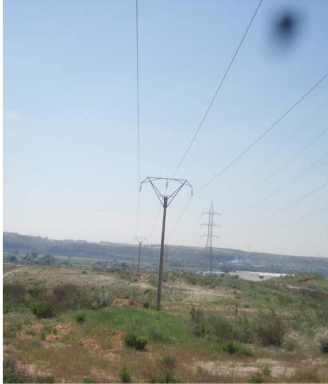
FOTO 5: Vista de la línea existente desde el apoyo 8 hacia Rivas. Paralelismo con línea de alta tensión 220 kV.
