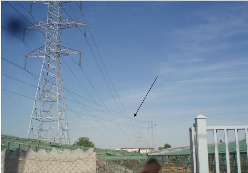
FOTO 11: Vano apoyos 19-18. Cruce con línea eléctrica 220 kV. Prohibición por sobrevuelo de edificación.
