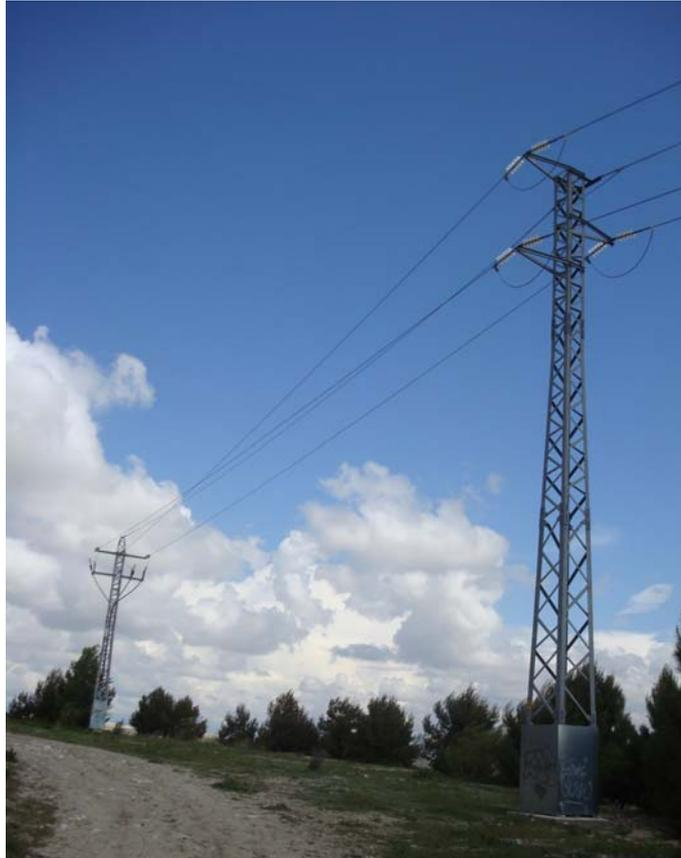
FOTO 19: Vano apoyos 44-45. Cambio de conductor LA 180 a LA 280.
