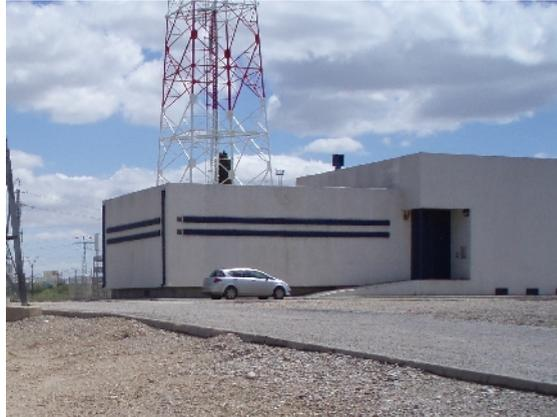
Se trata de un edificio de dos niveles; la planta baja, donde se instalan las celdas, y un sótano para el tendido de cables de potencia y transformadores de servicios auxiliares. También está dotado de instalaciones auxiliares, salas de mando y depósitos de recogida de aceite.
