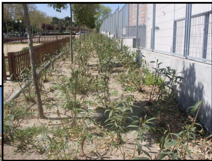
Cerramiento exterior de la subestación
