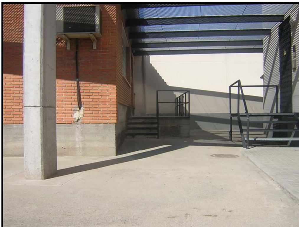
Foto 3: Entrada edificio 45 kV
