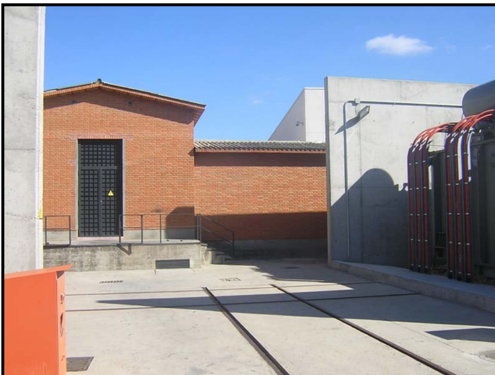
Foto 2: Vista entrada edificio 15 kV y lateral edificio 45 kV
