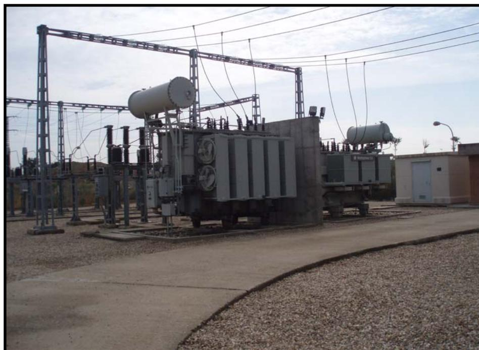
Foto 2: Vista de los trafos T-I y T-II separados por el muro cortafuegos.
