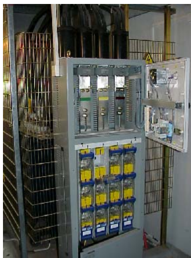
CUADRO DE BT CON BASES BTVC TRIPOLARES DE CORTE EN CARGA
