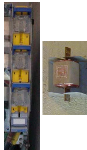
BASE BTVC CON EXTRACCION FUSIBLE DE CUCHILLAS
