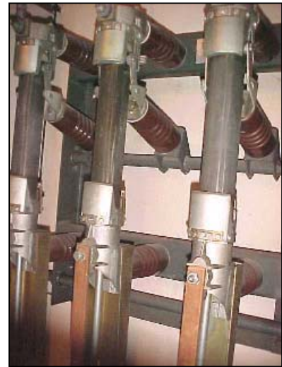
INTERRUPTOR-FUSIBLE DE CORTE AL AIRE
