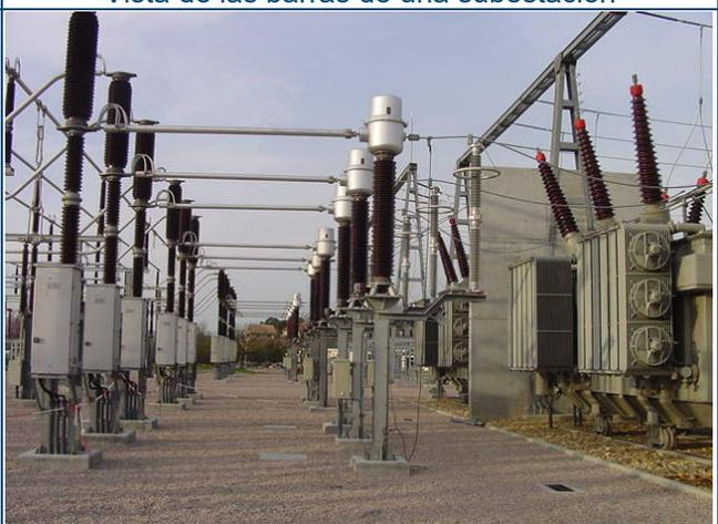
Posición de Transformador de subestación
