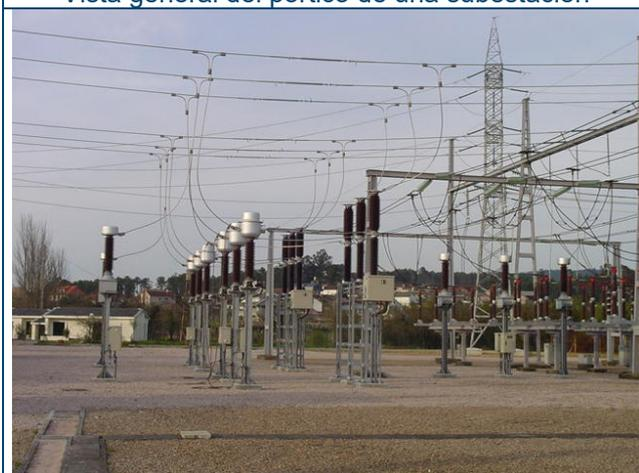
Posición de línea de una subestación
