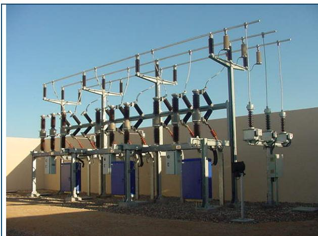
Subestación Modular intemperie de 45 kV
