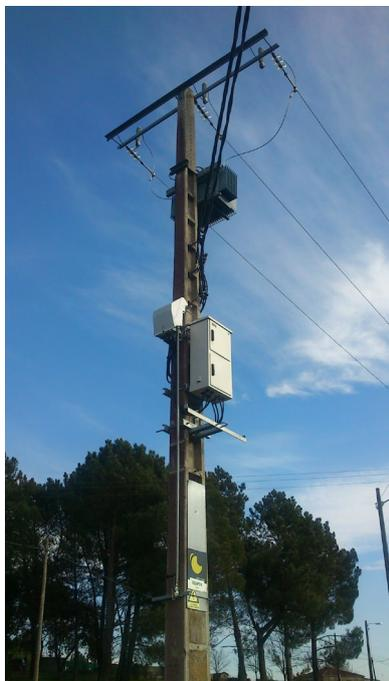
Instalación formada por un transformador de potencia reductor de Alta Tensión (tensiones 15 kV o 20 kV) a Baja Tensión (230 V/400 V), equipado con los elementos necesarios para su correcto funcionamiento, instalado al aire libre y que se halla ubicado sobre un apoyo.
