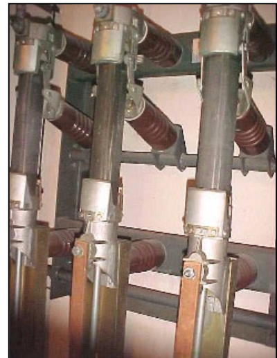
INTERRUPTOR-FUSIBLE DE CORTE AL AIRE
