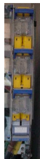
BASE BTVC CON EXTRACCION FUSIBLE DE CUCHILLAS
