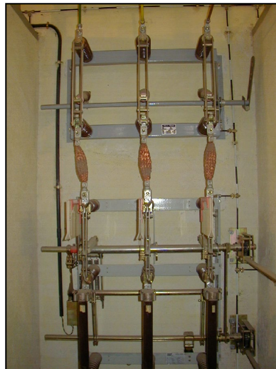
CELDA CONVENCIONAL DE PROTECCION DE TRAF0
