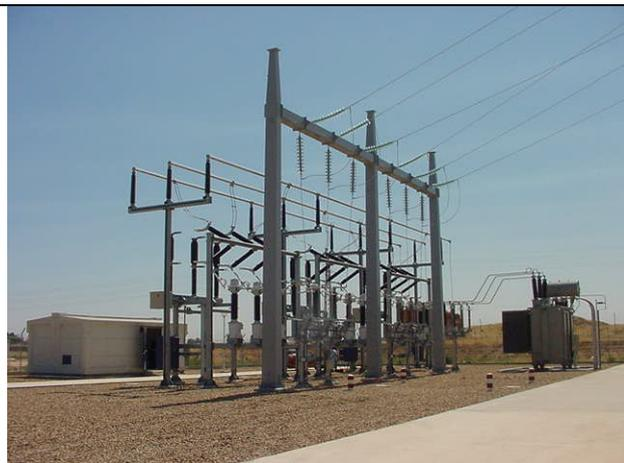
Subestación Modular intemperie de 132 kV
