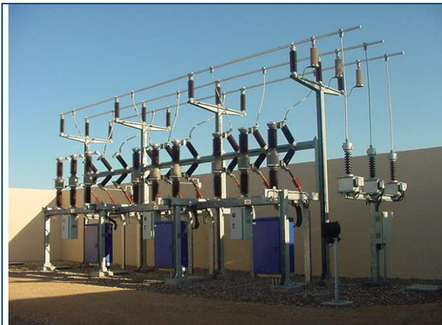
Subestación Modular intemperie de 45 kV
