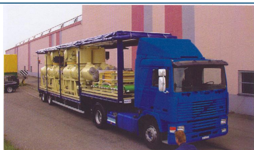
Transporte de Carretón 132 – 66 kV
