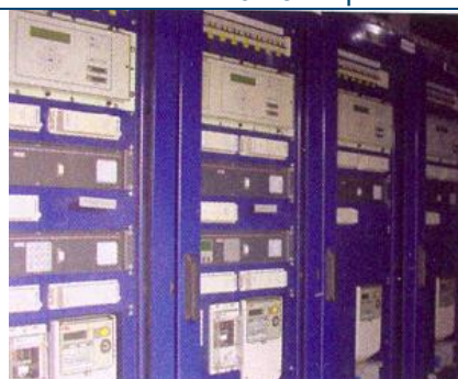
Vista interior con las celdas blindadas
