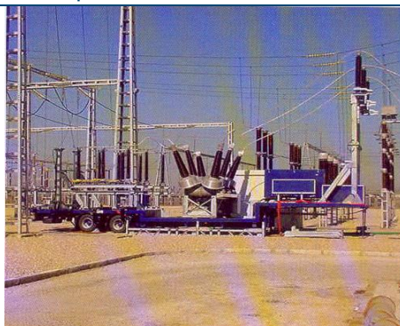
Posición situada en subestación en operación en sustitución de otra posición convencional fuera de servicio
