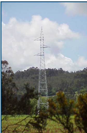
Apoyo de celosía
